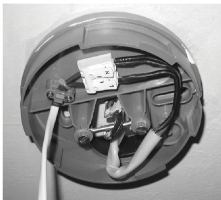
Рис. 94. Альтернативные варианты соединения электрических проводов от квартирной проводки к люстре
