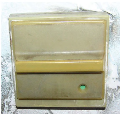
Рис. 64. Необычный клавишный выключатель с горизонтальным перемещением планки
