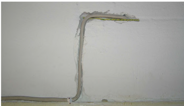
Рис. 76. Прокладка кабеля в гибридном исполнении
