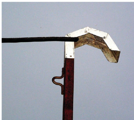
Рис. 92. Способ проводки кабеля и его заведение к устройству потребителя электроэнергии под углом 90^\circ
