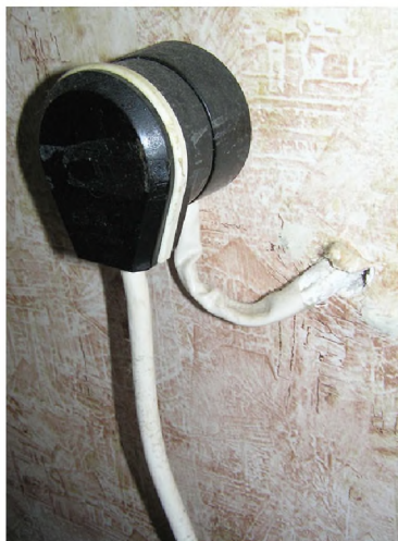
Рис. 80. Розетка мощной электрической плиты (с заземлением)
